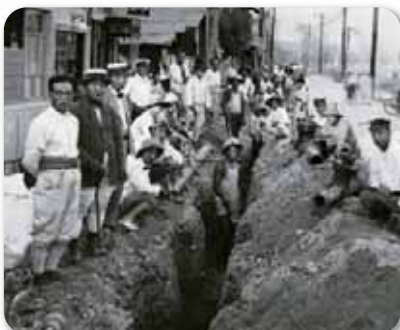
▲中心市街地への水道管理設工事
