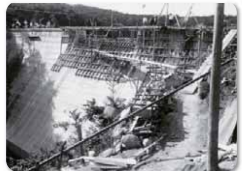
▲建設中の馬ヶ城ダム
