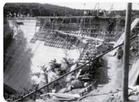
▲建設中の馬ヶ城ダム
