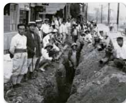
▲中心市街地への水道管埋設工事
