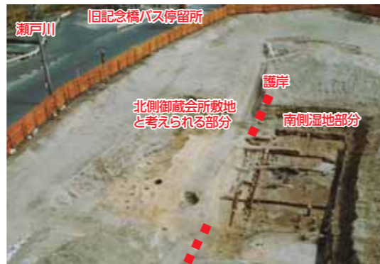
発掘調査で検出された御蔵会所南側の護岸
