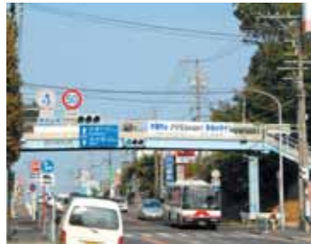
現在の東寺山町歩道橋
