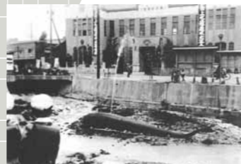
上水道しゅん工式
