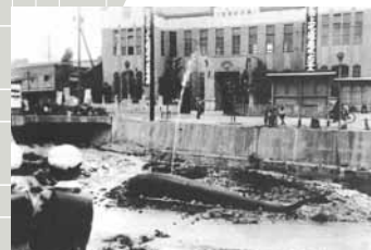
上水道しゅん工式
