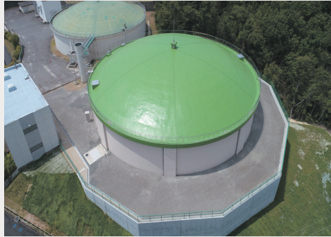
(穴田配水場 1・2号配水池 耐震性OK)
