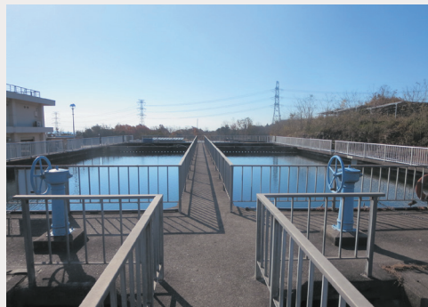
(蛇ヶ洞浄水場 沈澱池 耐震性NG)
