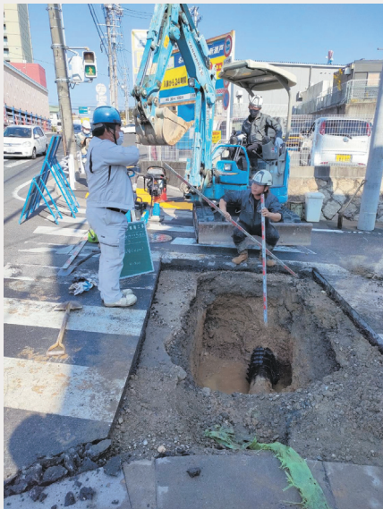
（管路修繕工事）
