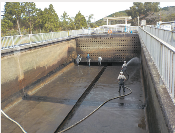
(蛇ヶ洞浄水場沈澱池 清掃状況)
