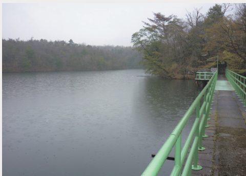
(馬ヶ城浄水場 貯水池(ダム) 耐震性不明(レベルI※3OK))
