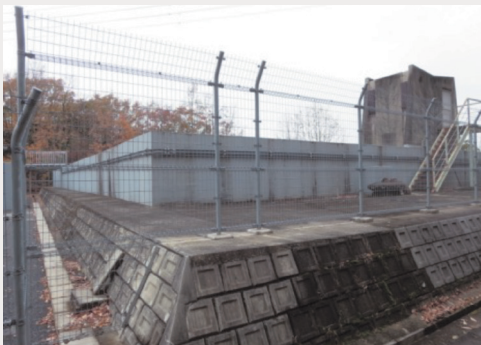
(菱野団地低区配水場 1・2号配水池 耐震性NG (レベルI ※3 OK))
