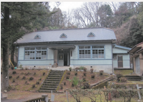
(馬ヶ城浄水場 管理棟 耐震性NG)
