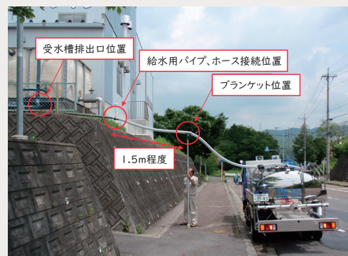
（民間の給水施設からの給水訓練状況）
