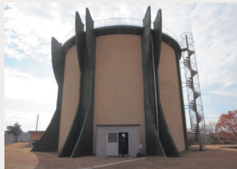
(南山口配水場 配水池 耐震性NG)
