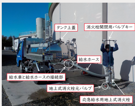
（穴田配水場 1号配水池からの給水訓練状況）
