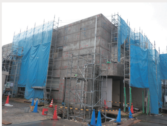
（穴田配水場 管理棟の耐震補強工事）
