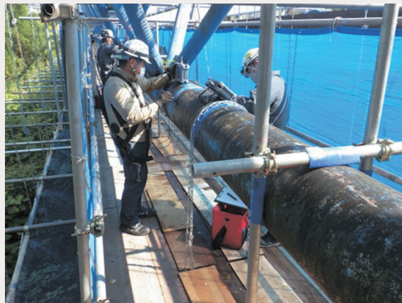
（幡山橋水管橋点検状況）
