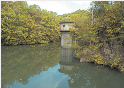
(蛇ヶ洞取水場 取水塔 耐震性NG)
