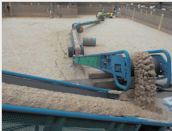
(馬ヶ城浄水場緩速ろ過池 ろ過砂の入れ替え状況)
