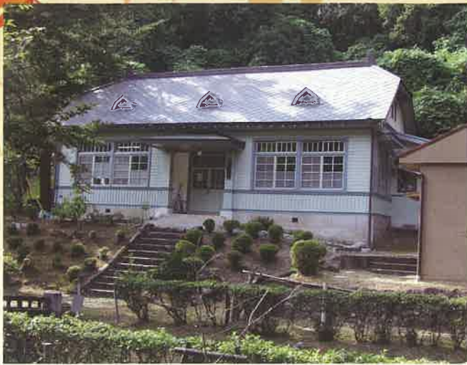
馬ヶ城浄水場 管理棟
