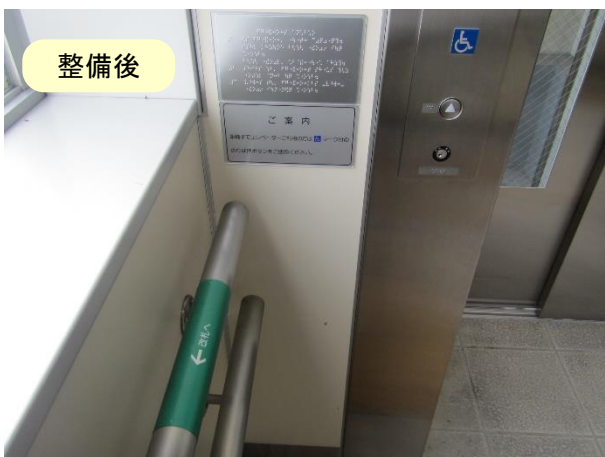
手すりの改善、点字の設置
