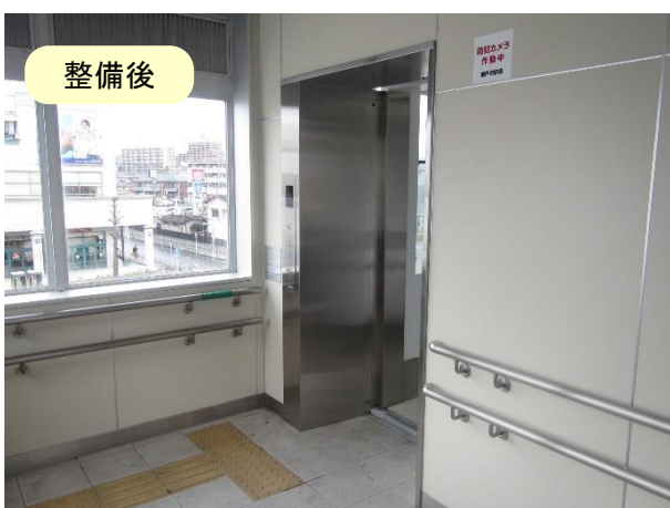
エレベーターの整備
