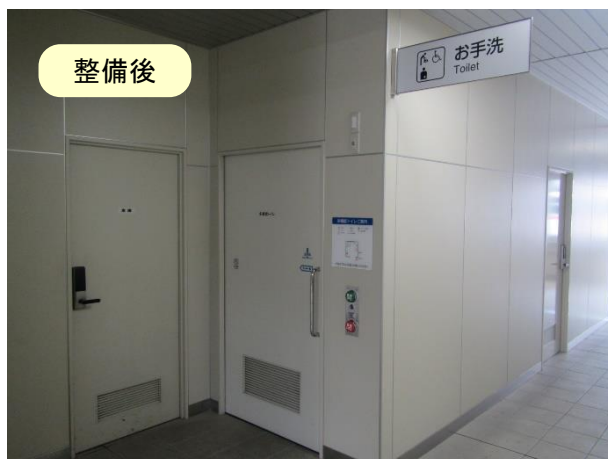
多機能トイレの整備
