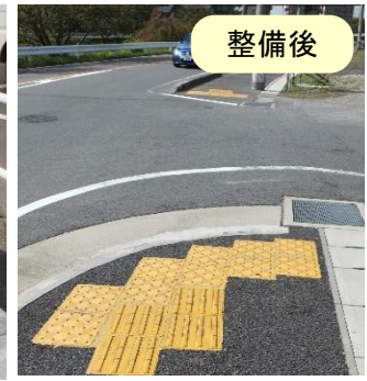
視覚障害者誘導用ブロックの整備
