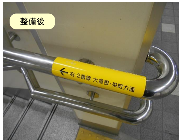
手すりの改善、点字の設置
