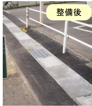
側溝蓋の整備
