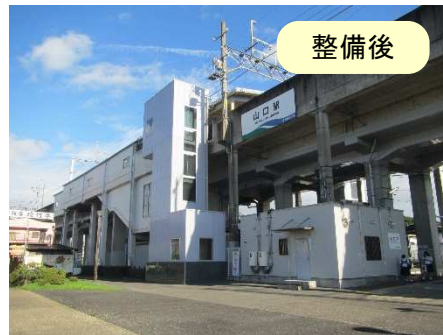
山口駅エレベーター設置
