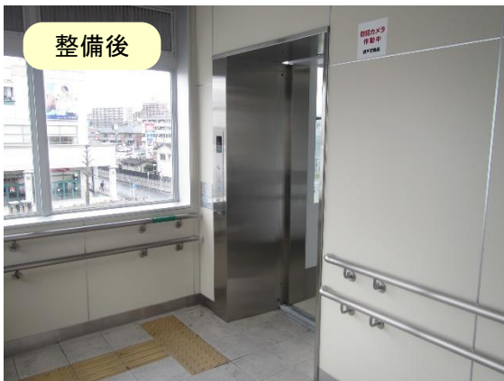
エレベーターの整備
