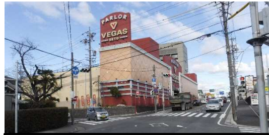
現在の法令に適合しない線形の ループ状道路構造を見直し
