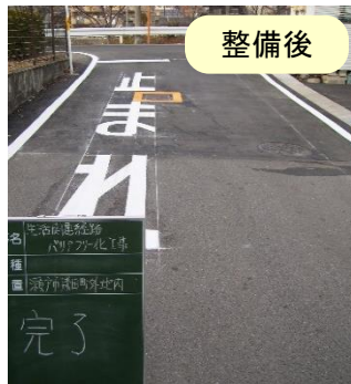
歩道の横断勾配の改善
