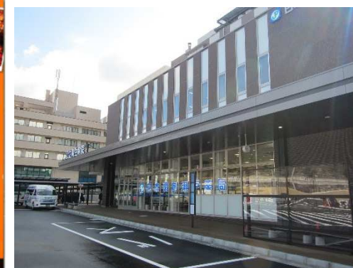
風よけフェンスの設置
