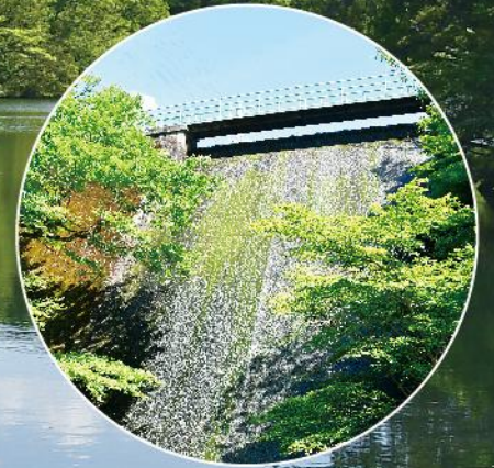
馬ヶ城浄水場
