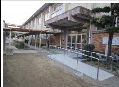
校舎玄関にスロープを設置
