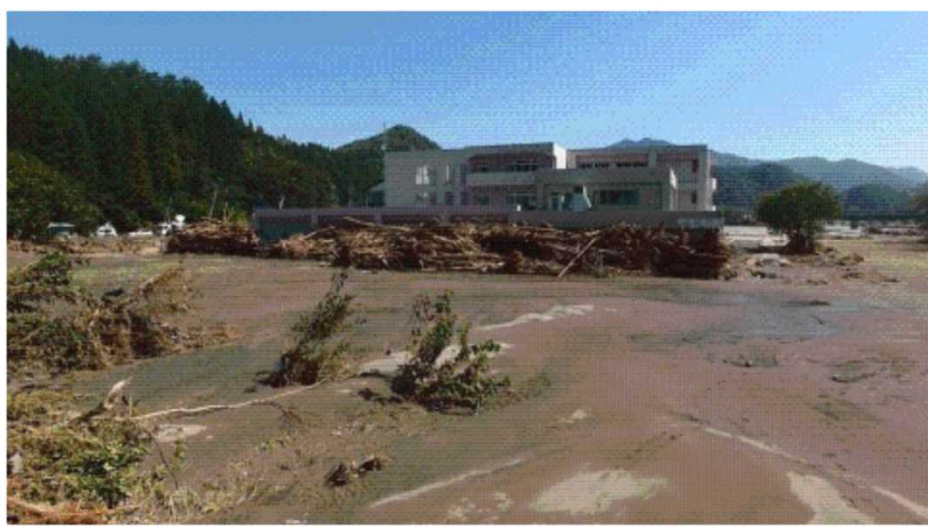
平成28年台風第10号による被害状況
