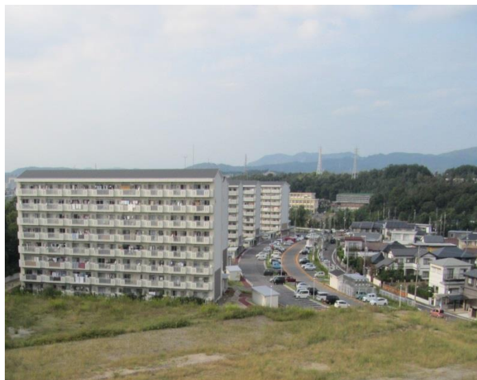
建替が進む原山台の県営住宅
