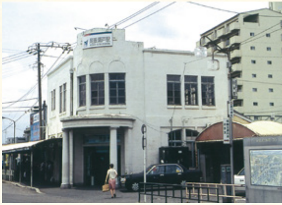
▲名鉄尾張瀬戸駅(旧駅舎) 平成11年(1999)
