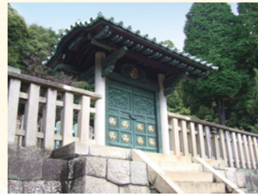
▲源敬公廟(国指定建造物)
