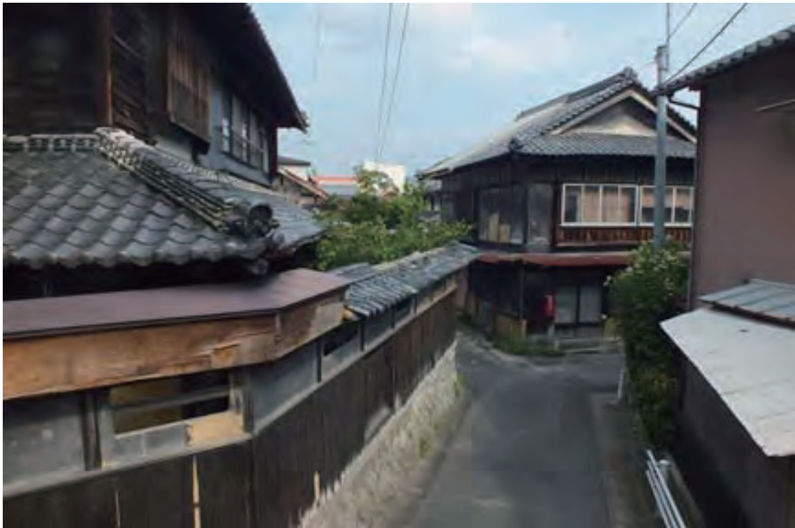
旧山繁商店の外観（西より）
