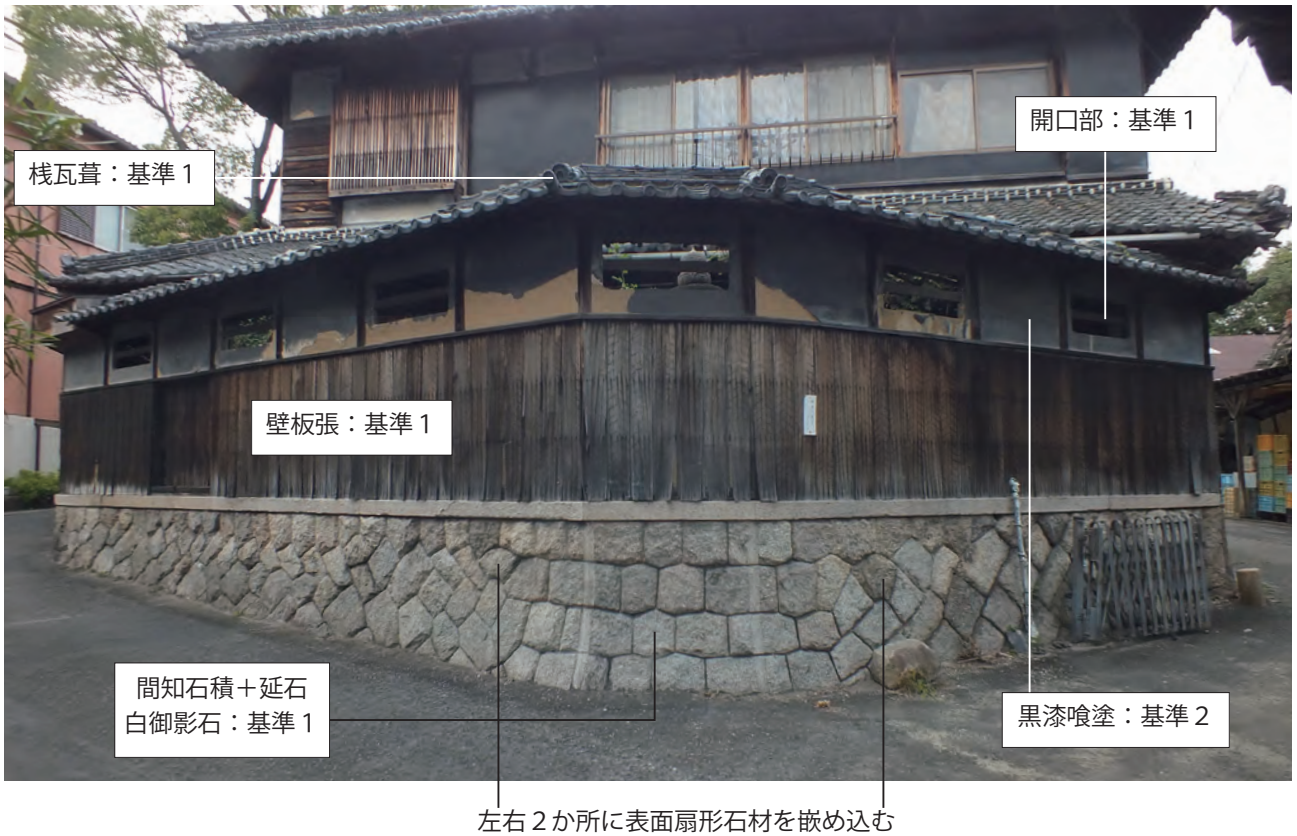
【塀】外部外観 南より
