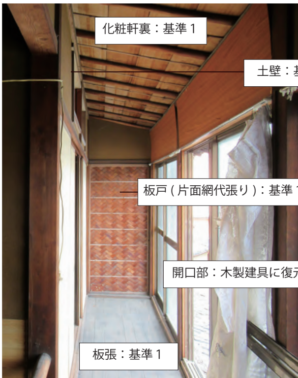
【離れ】2階北廊下 東より
