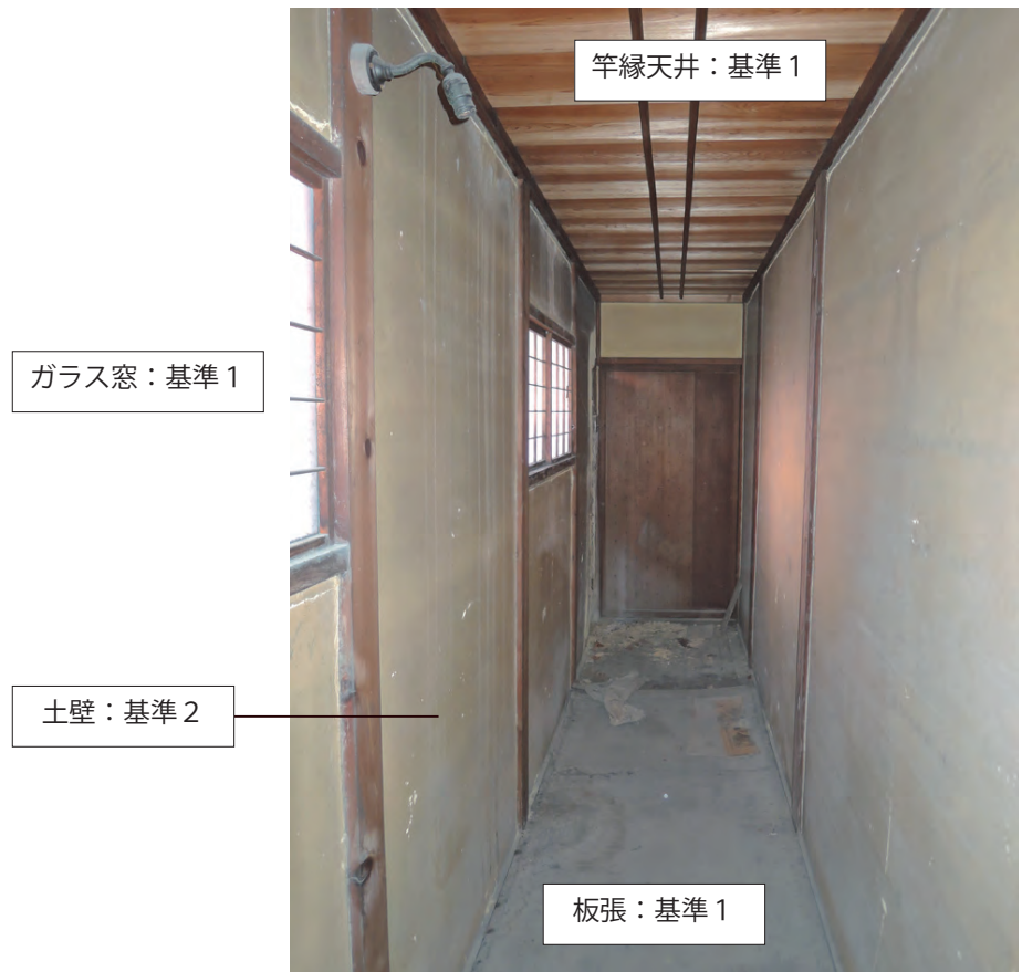
【離れ】1階西縁 南より
