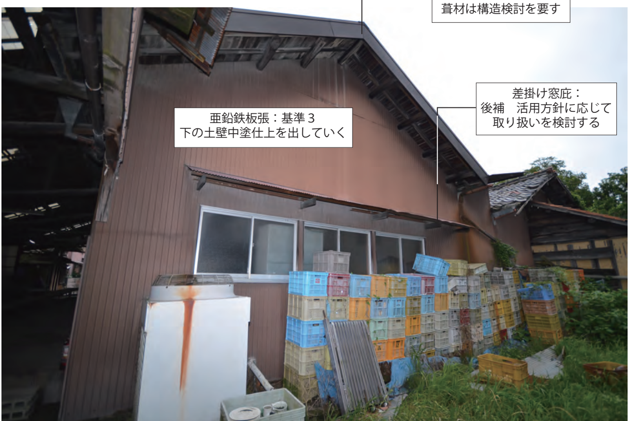
【前倉庫】外観東面 南東より
