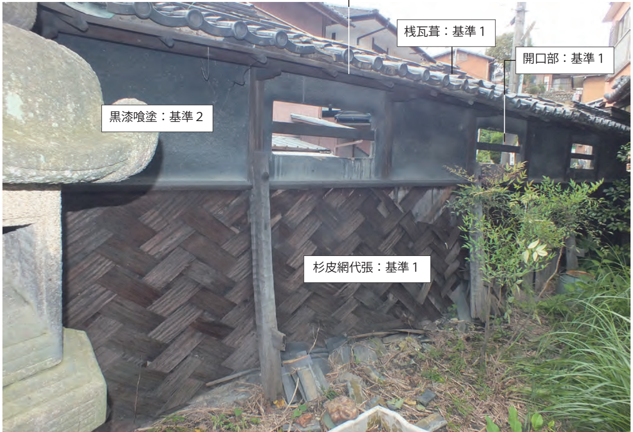
【塀】内部外観 東より
