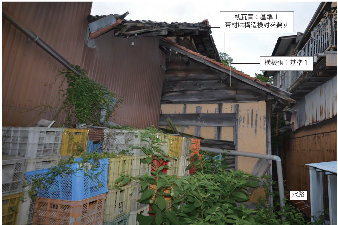
【中倉庫】外観東下屋 南より
