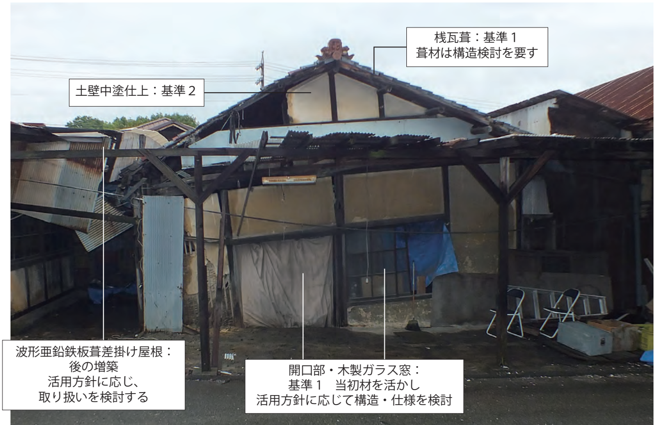
【中倉庫】外観西面 西より
