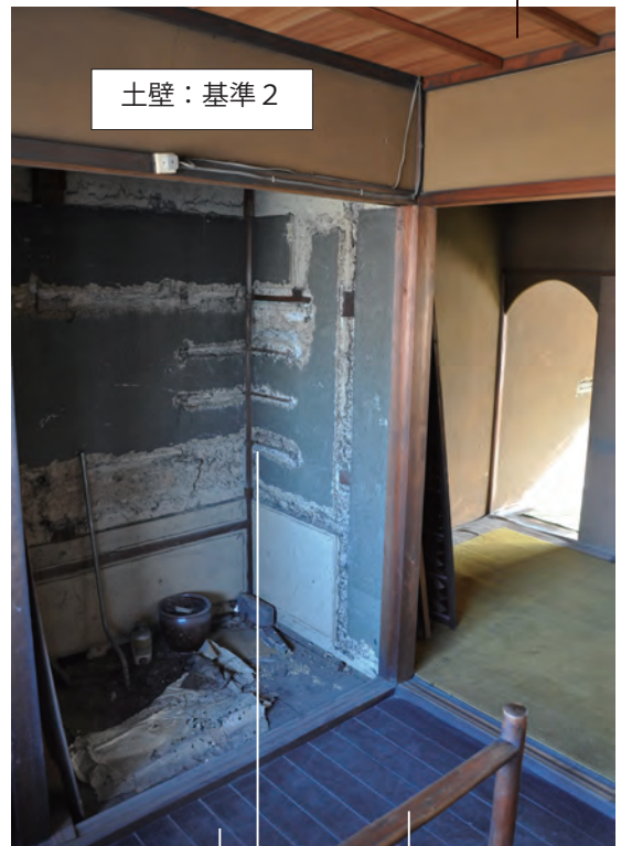
【離れ】2階北廊下水屋 北西より
