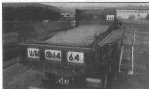
防塵シート設置状況
