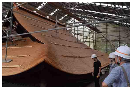
定光寺本堂保存修理工事 工事見学会
