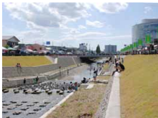
写真 7-2 一級河川瀬戸川
