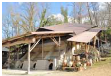
写真 6-1 やきもの文化を強く印象付ける建造物の例 (一里塚本業窯)
