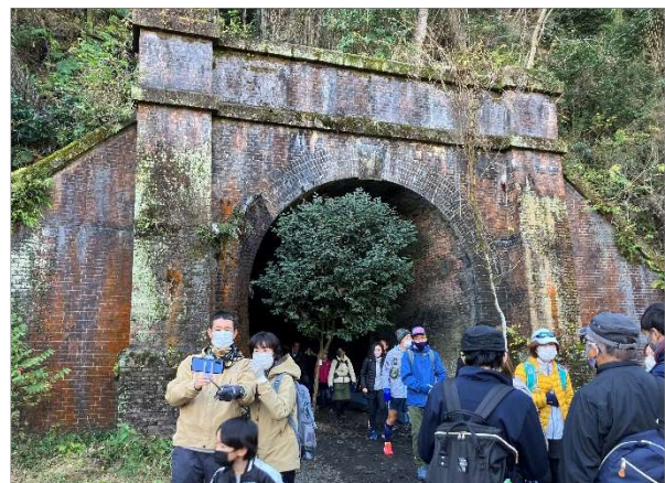
6号トンネル(東側入口)
