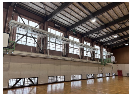
水野中学校 体育館
