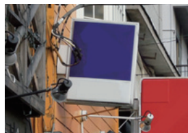
上部構造全体の傾斜、 ぐらつき
