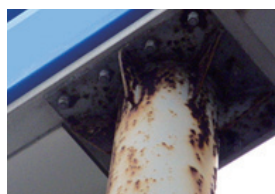
鉄骨接合部（溶接部・プレート）の 腐食、変形、隙間
