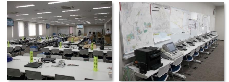
■ 災害対策本部運営室(仮称)における通信機器や机等の常設設置の例 (写真:袋井消防庁舎・袋井市防災センター)
