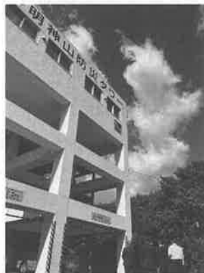
明神山防災タワー
