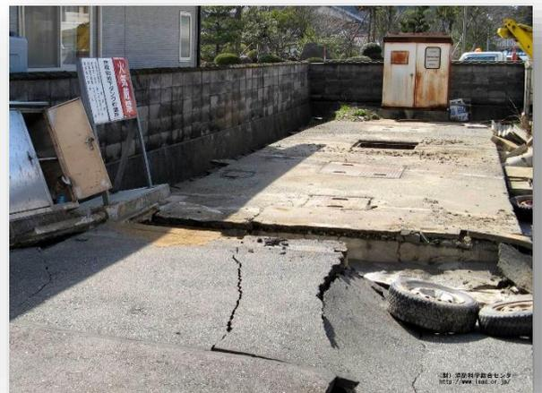
出典：(一財)消防防災科学センター「災害写真データベース」平成19年(2007年)能登半島地震 輪島市門前総合支所敷地の被害と液状化の跡
