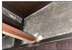
・壁面の漆喰が剥落
