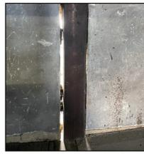
・壁と柱の間に大きな隙間
