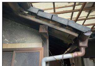
・野地板と瓦の間の土が露出している
