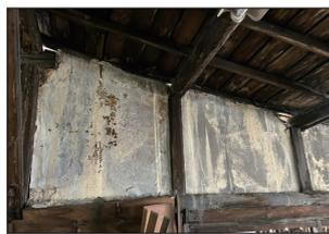
・壁面と天井の間に隙間
