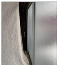
・窓枠上部の装飾材が外れている
