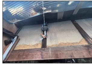
・壁面に雨漏りの跡
