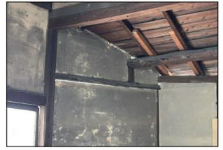
・壁面と天井の間に隙間
