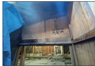
・外壁面の漆喰 剥落
