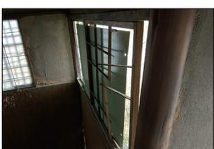
・窓の木枠が破損
