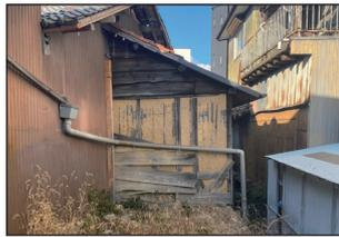
・板張り 一部欠損 土壁・柱露出
