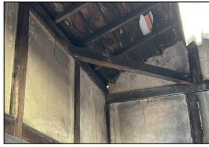
・壁面と天井の間に隙間
