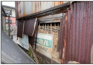
・トタンが剥落し土壁が露出
