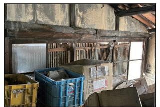
・窓がガルバリウム鋼板で応急処置
