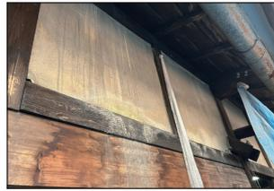
・壁面に雨漏りの跡
