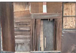
・壁面のベニヤ板張りが欠損
