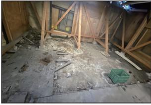
・床材が剥がれ、コンクリートが露出
