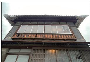
・窓下の板が破損している
