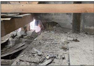
・床と壁の接続部分に破損
