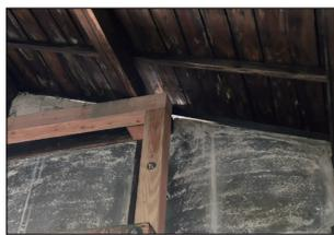
・壁面と天井の間に隙間
