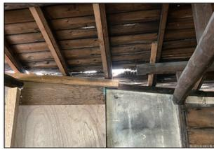
・壁面と天井の間に隙間
