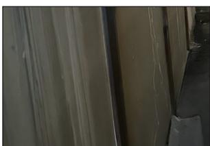
・壁面に雨漏りの跡
