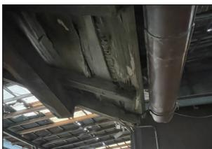
・垂木、野地板が破損している
