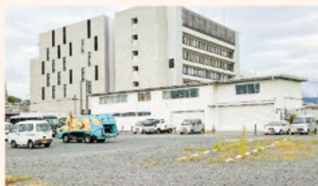
消防新庁舎建設予定地
