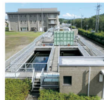
水野浄化センター
