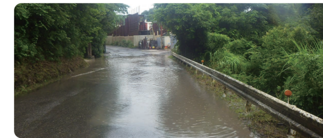
山路海上線冠水の様子
