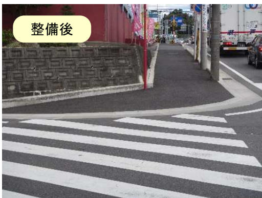
交差点の段差解消 (市道共栄追分線)
