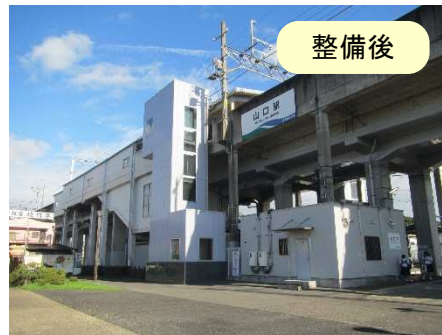
山口駅エレベーター設置
