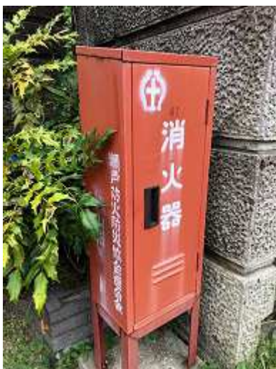
街頭消火器設置整備事業
