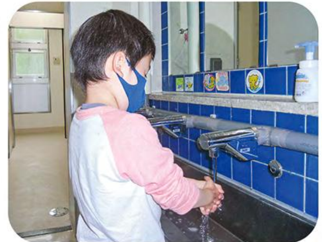
自動水栓の設置(掛川小)
