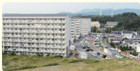
建替が進む原山台の県営住宅
