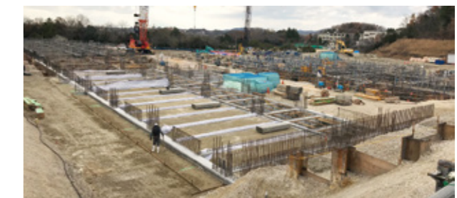
現在建設中のにじの丘学園
