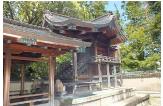
市指定 陶彦社 本殿・幣殿・拝殿・築地塀 大正期
